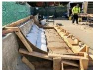
3 pav. Lenktos armatūros įrengimas.
