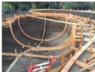
3 pav. Lenktos armatūros įrengimas.
