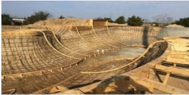
2 pav. Medinių klojinių montavimas.
